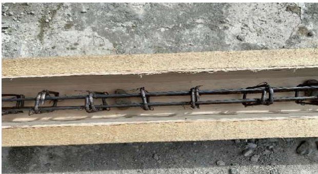
Gambar 7. Tulangan dan bekisting balok
